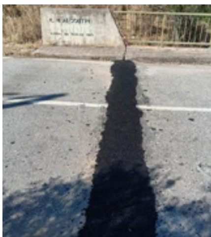
Trabalhos de manutenção na Ponte da Ribeira do Vascão Giões
