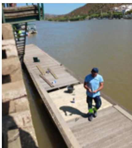
Reparação de plataformas no Caís Alcoutim
