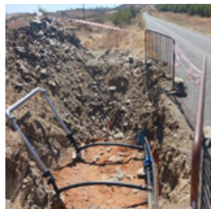
Instalação de válvulas redutoras de pressão no sistema de abastecimento de água Castelhanos e Fonte Zambujo de Baixo
