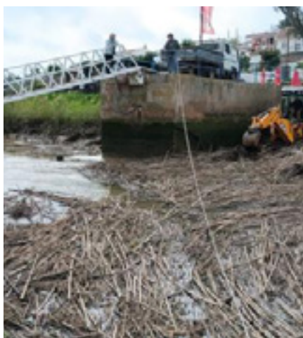
Trabalhos de limpeza de canas Rio Guadiana
