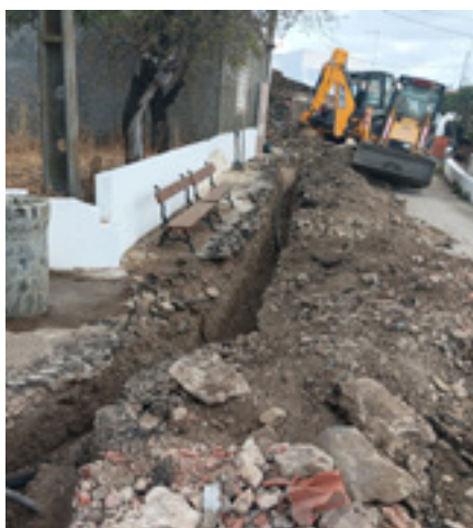
Ampliação da Rede de Abastecimento de água Diversas localidades
