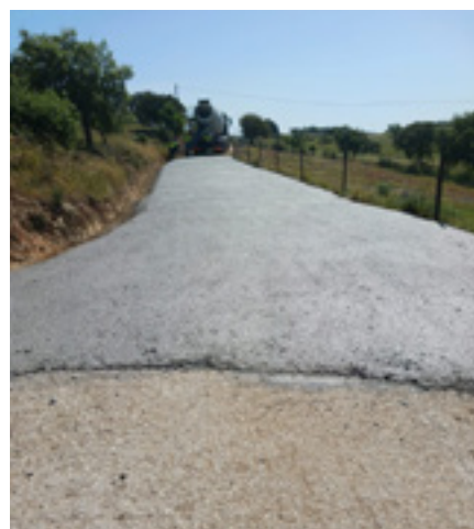
Reparação de arruamento Azinhal
