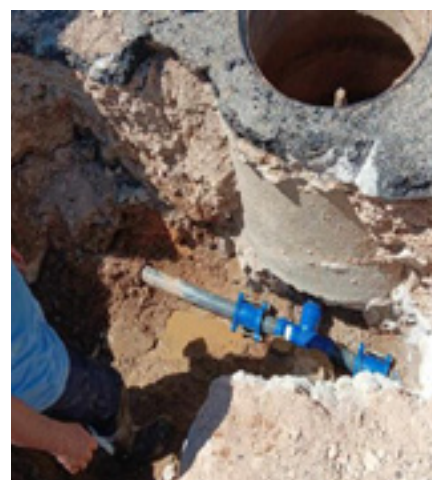
Reparação de roturas em diversas localidades
