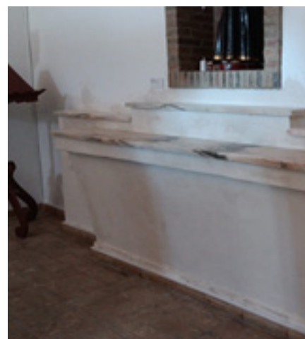
Trabalhos de recuperação reboco e pintura na Capela de Santo António Alcoutim
