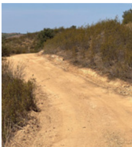
Trabalhos de reparação de caminhos agrícolas Concelho de Alcoutim
