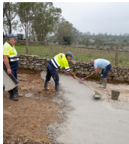
Reparação de arruamento Pereiro
