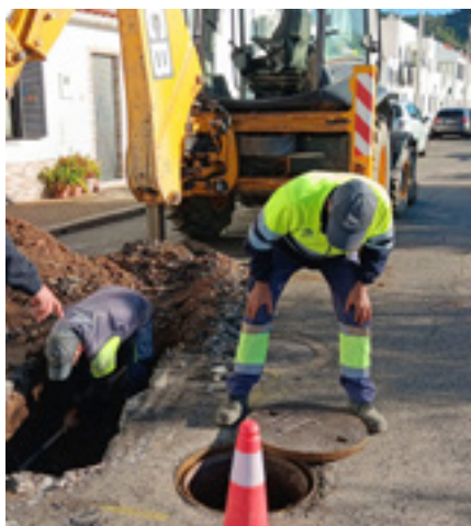
Reparação de roturas Alcoutim
