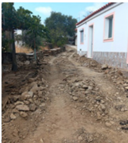
Reparação de arruamento Zambujal
