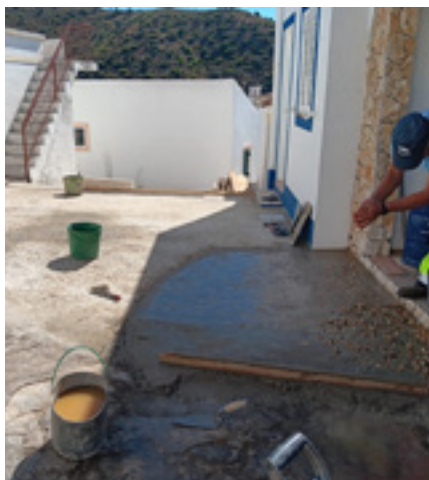
Reparação de Arruamento Guerreiros do Rio
