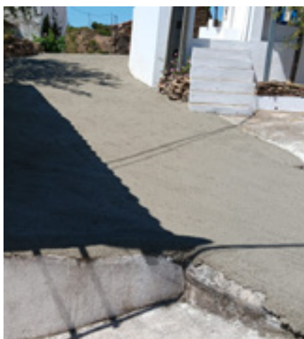
Reparação de arruamento Fortim
