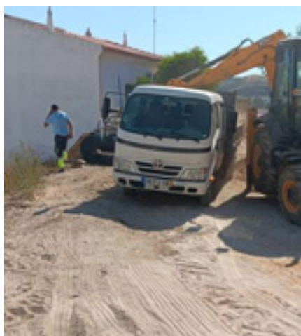
Execução de muro de contenção de terras Alcoutim
