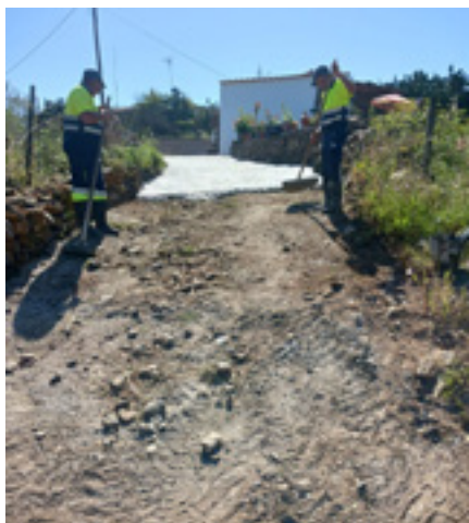
Reparação de Arruamento Pessegueiro
