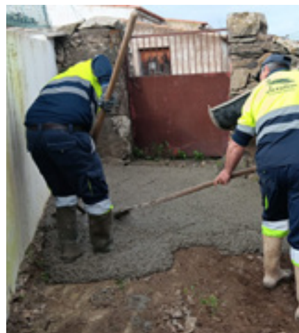
Reparação de Arruamento Balurcos
