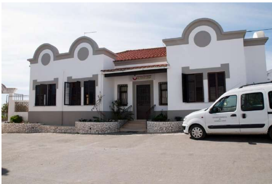
Fotografia 5-6 - Centro Paroquial de Martim Longo (fotografia: João Belard)
