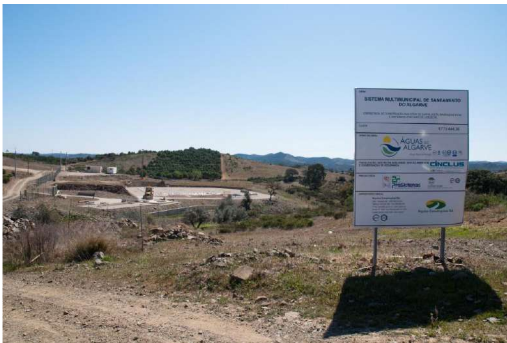
Fotografia 5-7 - Obras da ETAR da Barrada (fotografia: João Belard)
